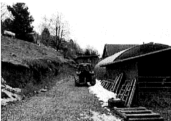
Le "tunnel" de l'étable actuelle situé en partie Nord de la ferme.
